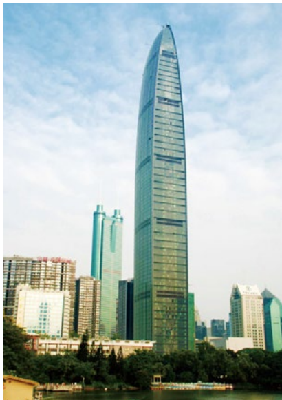
绿色建筑京基100大厦
